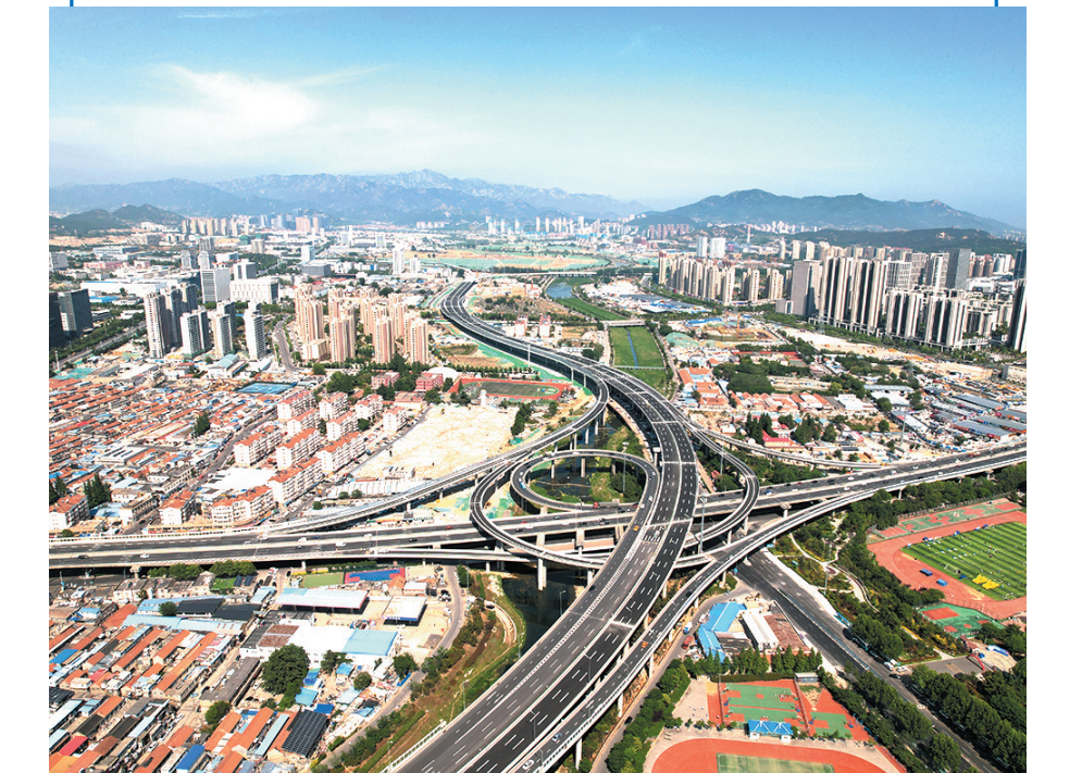
■巨源建工参与建设的跨海大桥高架路二期工程。
