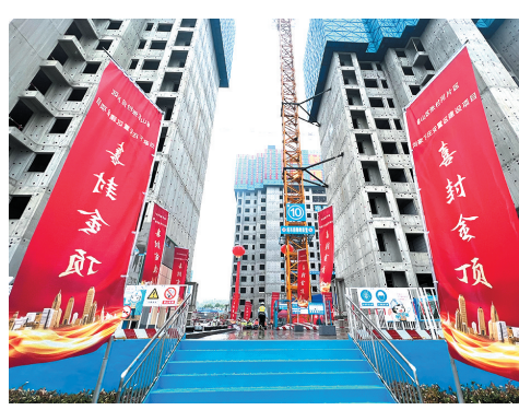
■5月28日上午9点,崂山区中韩街道刘家下庄社区村庄改造安置区项目“喜封金顶”。这是张村河片区安置区项目中首批封顶的楼座,较原计划提前7个月。刘家下庄社区安置区占地61.95亩,共建设14栋16层至18层住宅,1栋3层社区用房,安置居民940户。 此次封顶为全新起点,接下来,张村河片区将全力推动桔桃、中韩两个社区上半年完成签约工作,较原计划提前一年半实现张村河片区城中村清零。 衣涛 摄影报道
