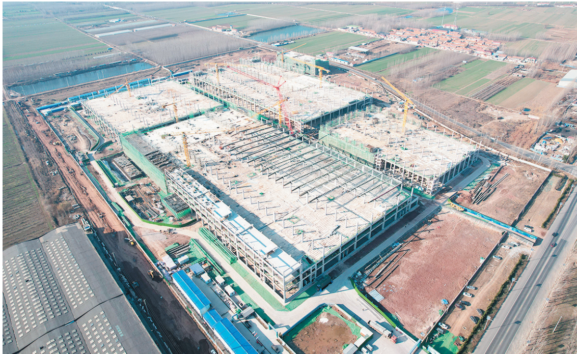
■海尔卡奥斯工业互联网生态园项目建设现场。
