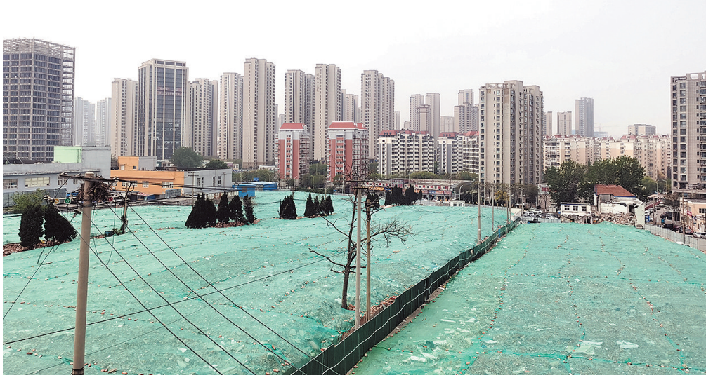
河西剩余片拆除接近尾声,拆除后的地面都铺上了绿色防尘网。
