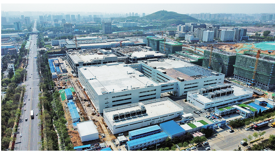
建设中的青岛市虚拟现实产业园。
