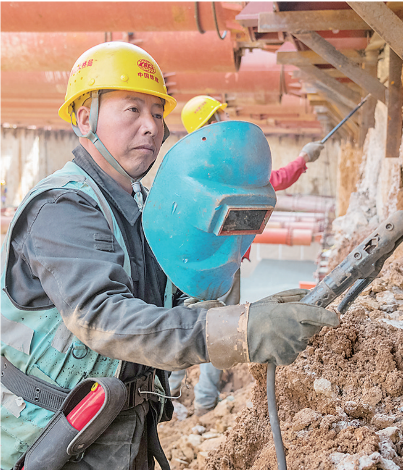
■在地铁2号线东延线汉川路站，施工人员刘春安装基坑钢围檩。 杨志文 摄
