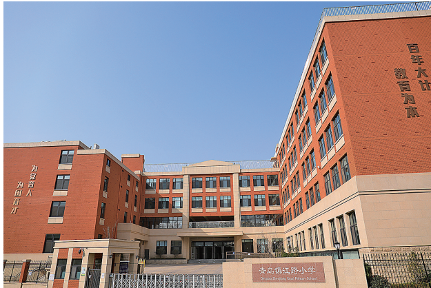
■青岛镇江路小学整体风貌。
