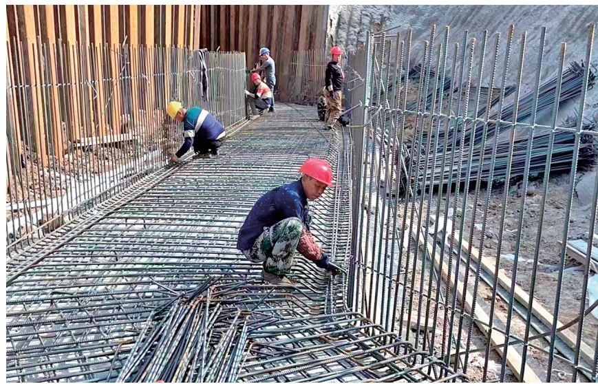
■即墨中山街进入电力管廊施工阶段。
