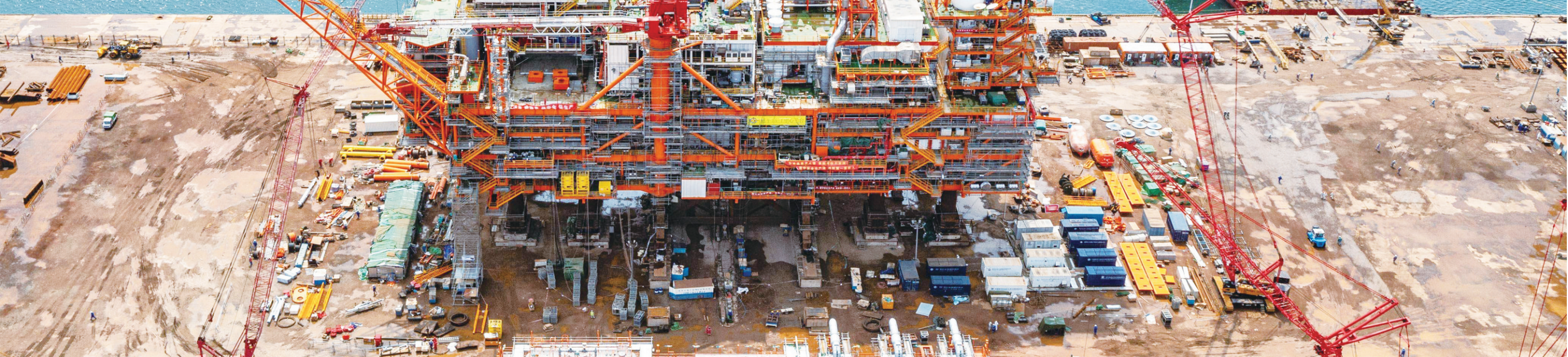
■我国海上首个二氧化碳封存示范工程设备在青建造完工。
