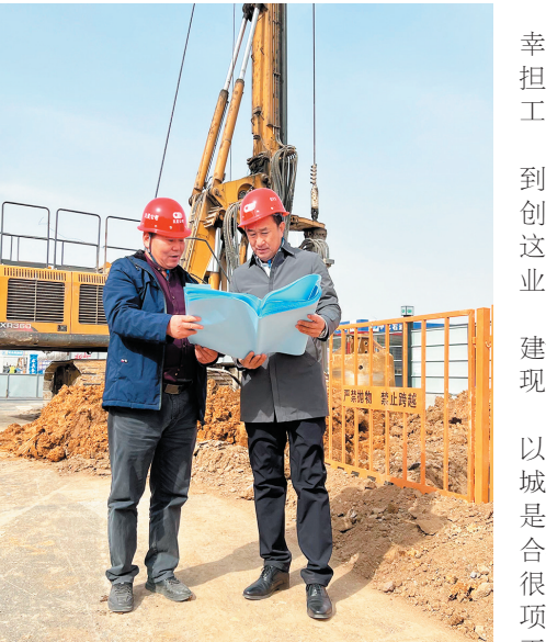
■王正华(右)在施工现场调度项目进展。
