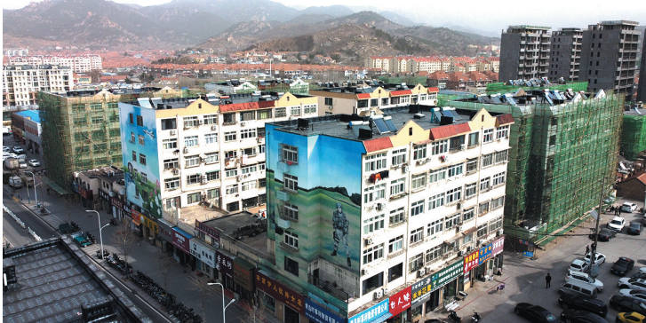
■沙子口供销社小区正在开展加装保温层施工。
