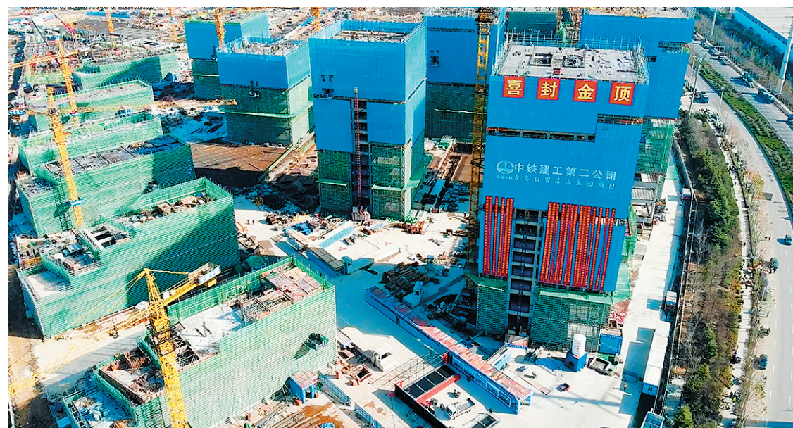
■青岛自贸片区航运贸易金融融合创新基地项目现场。
