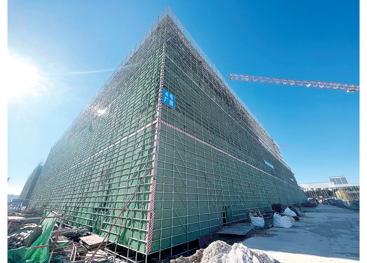
■青岛虚拟现实产业园整机和光学模组项目现场。
