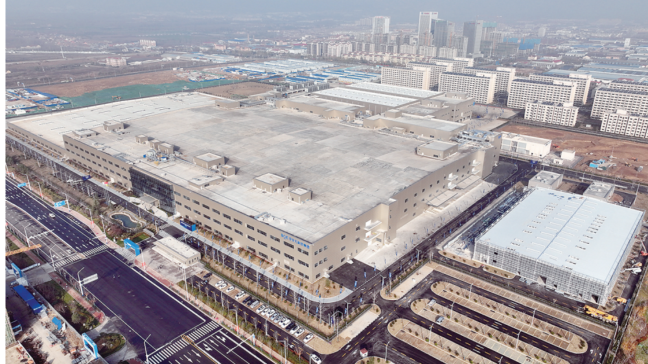
■建设中的青岛京东方光电科技有限公司。
