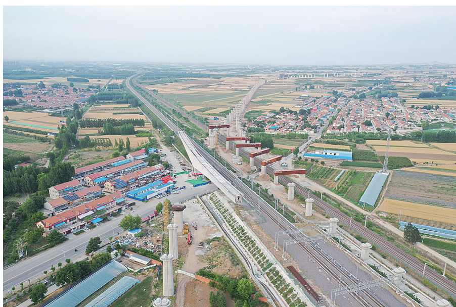
莱荣高铁莱西段在加速建设中。
