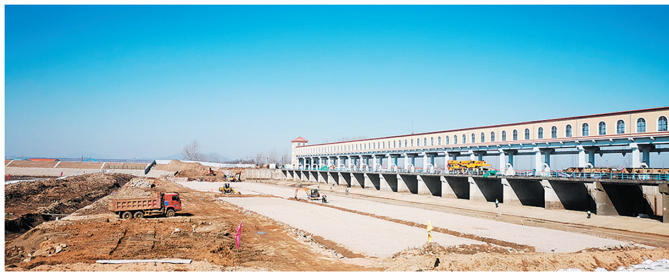
■白马河拦河闸维修加固工程施工现场。
