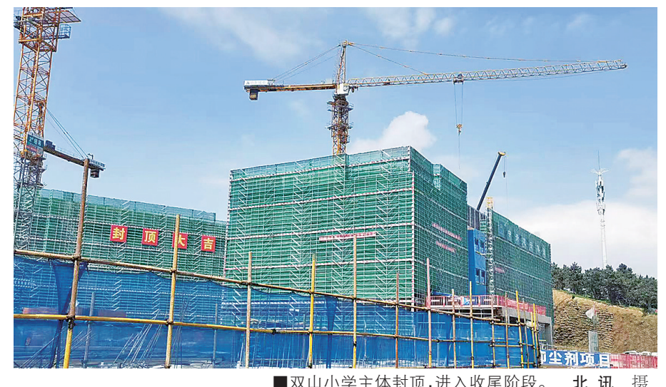
■双山小学主体封顶,进入收尾阶段。 北讯 摄
