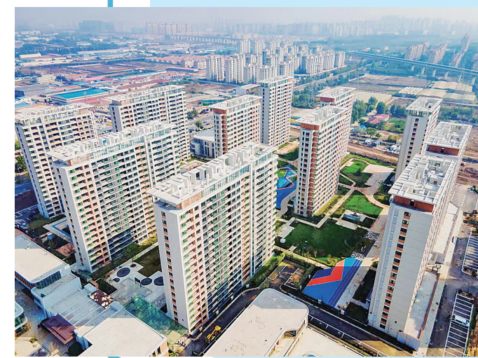
■更新改造后，青岛城中村面貌发生翻天覆地的变化。
