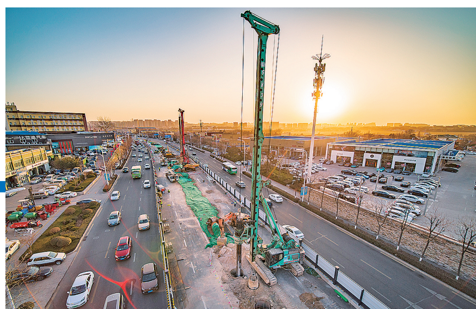
■重庆路快速路桩基施工现场。
