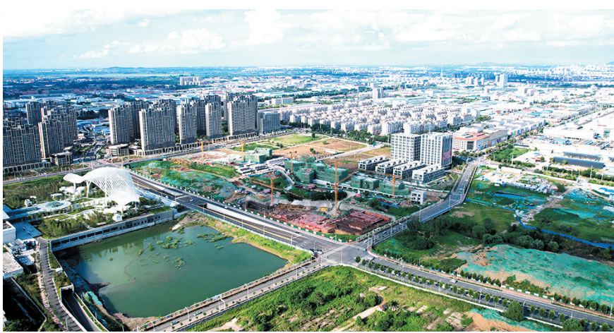
■正在建设中的即墨北站低效片区。
