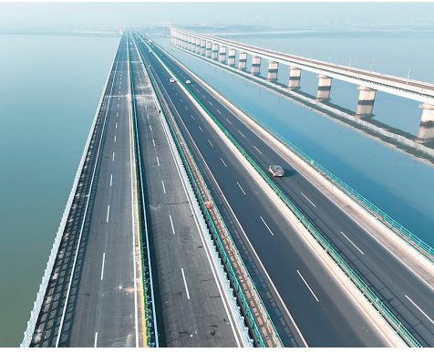
■青兰高速双埠至河套段改扩建工程新建南幅完工。
