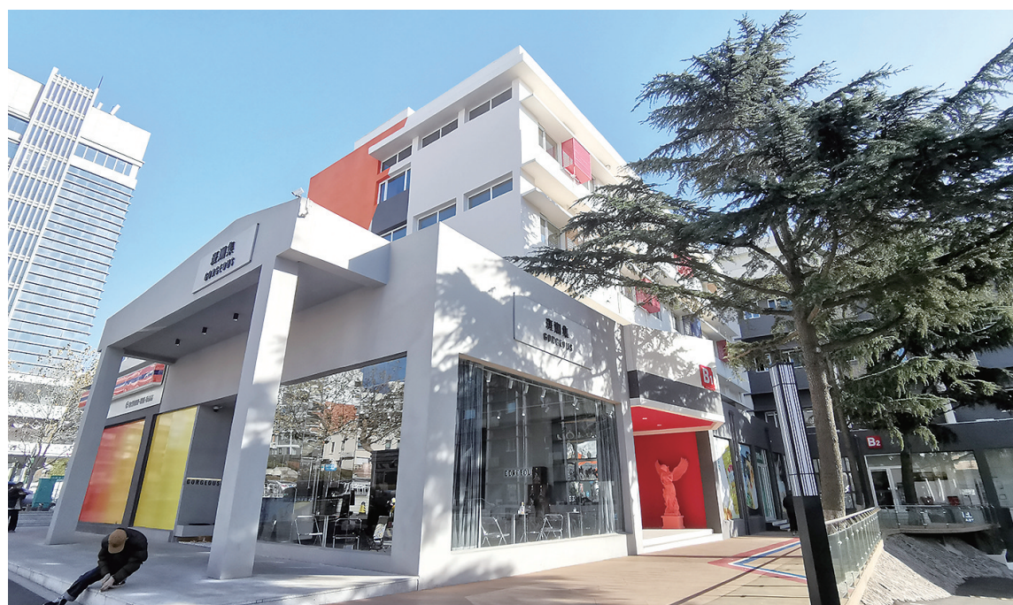
■改造后的延安三路109号植入了新业态。王萌摄
