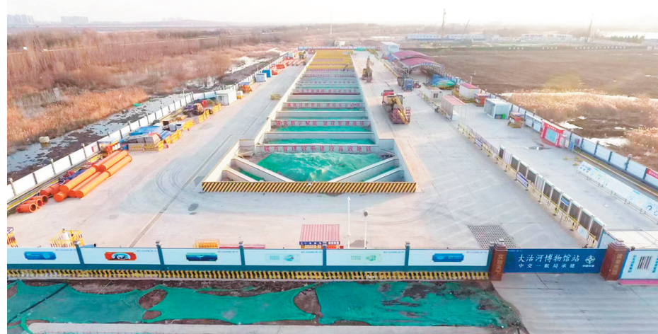
■地铁8号线支线大沽河博物馆站施工正加快推进。
