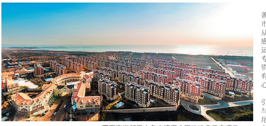
■西海岸新区南岛小镇棚户区改造安置房项目。
