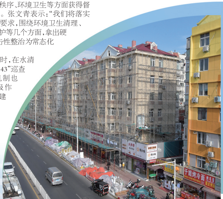
台东附近老旧楼院正在提升改造。崔冬妮 摄
