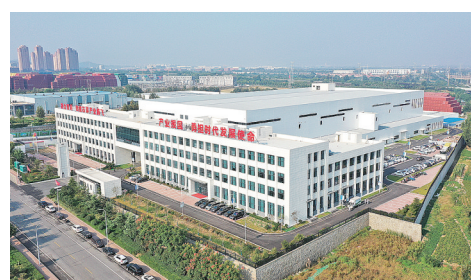
■青岛光电产业园研究院及高端装备项目。
