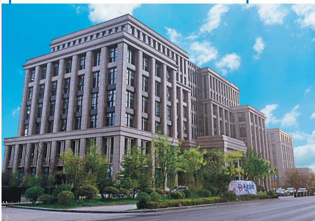
■青岛华通集团总部大楼。
