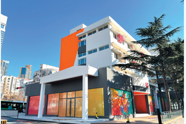
■由原延安三路109号海珊制衣厂改造的云芯产业园。
