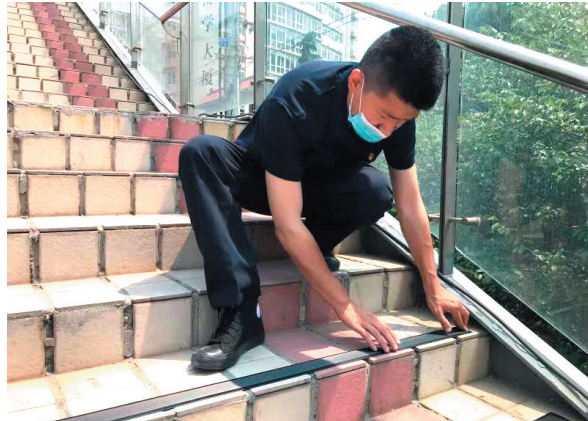
■同安路天桥铺设防滑条。 市北区城管局供图
