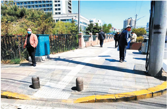
■新建的无障碍坡道。 市北区城管局供图
