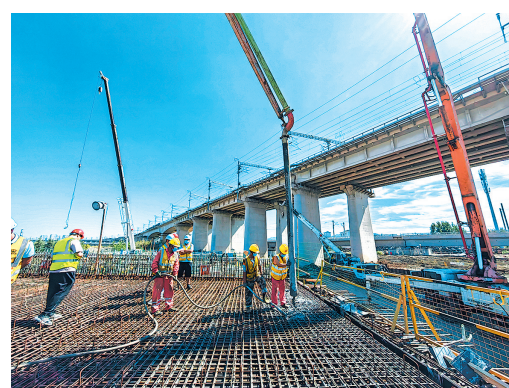
唐河路-安顺路打通工程娄山河桥首跨涉铁刚构桥浇筑现场。
