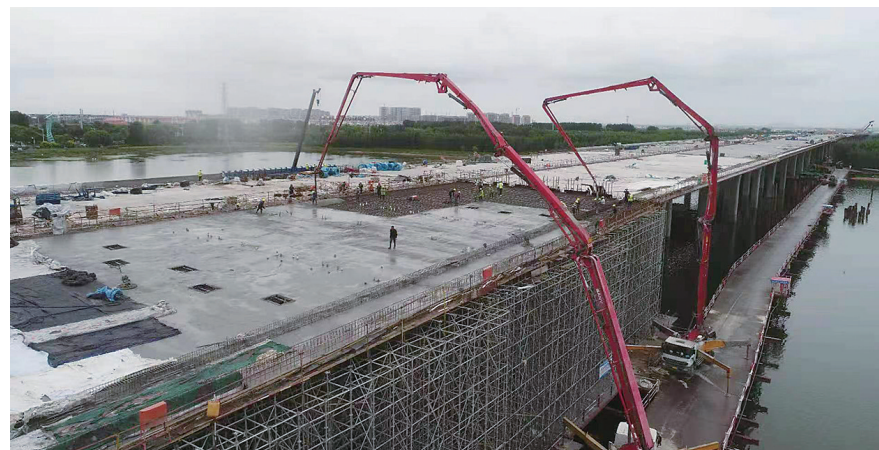
■国道204大沽河桥梁工程主河道梁体正在施工。
