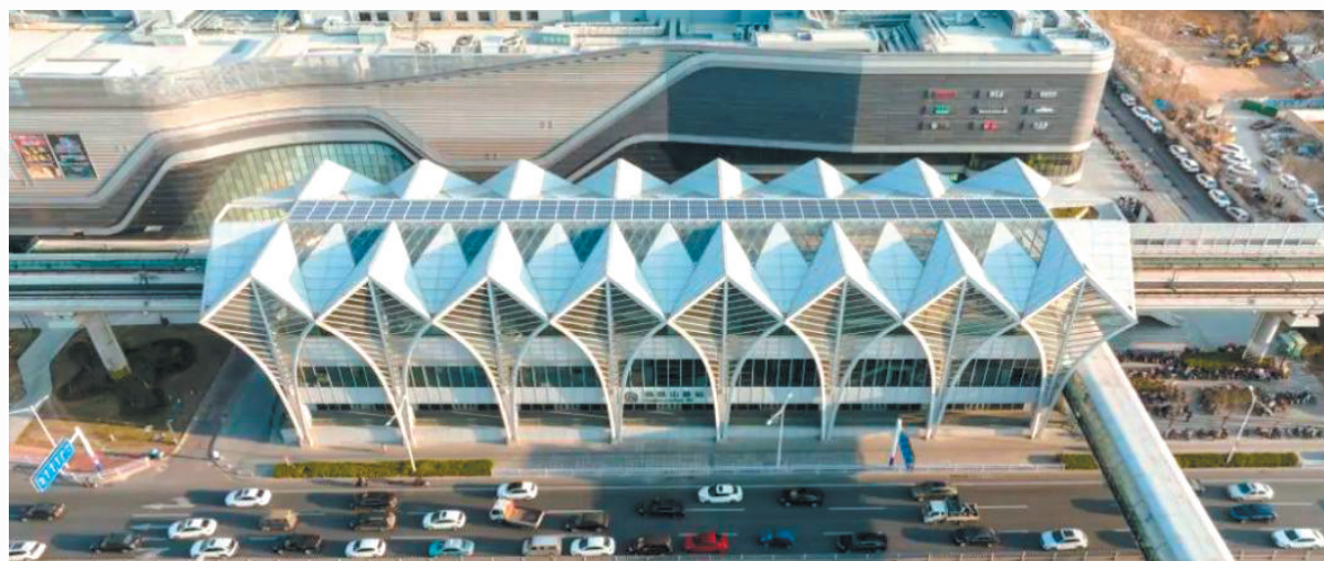
■青岛地铁13号线凤凰山路站光伏一体化车站。
