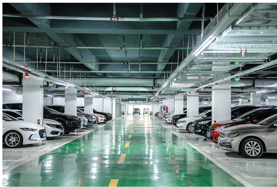
■李村路停车场利用地上、地下空间提供车位500余个。刘栋 摄
