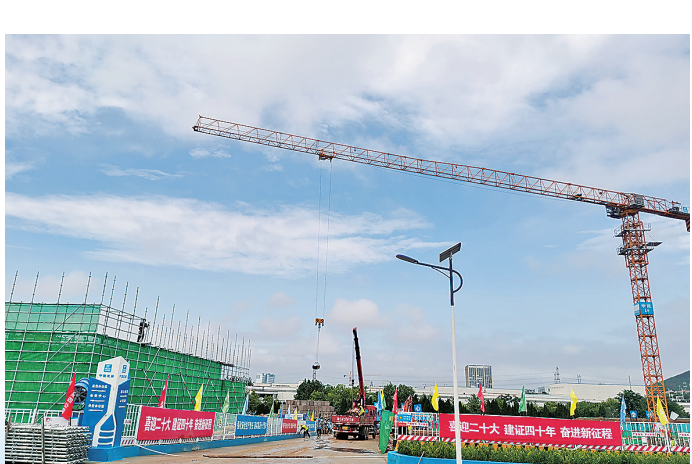
■建设中的青岛虚拟现实产业园。
