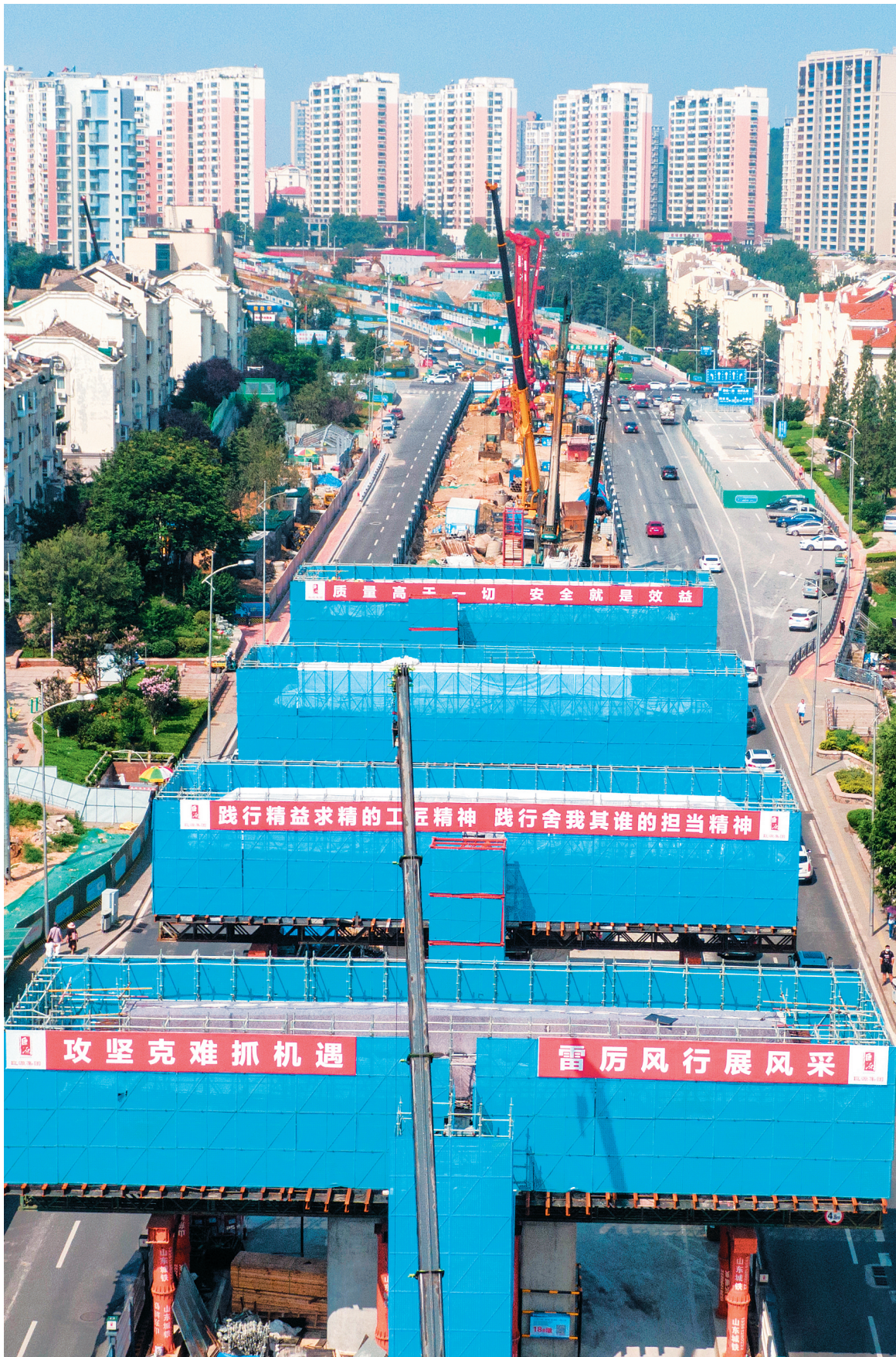
■辽阳路快速路(福州路—海尔路段)工程施工现场，一组组高大粗壮的墩柱已拔地而起。
