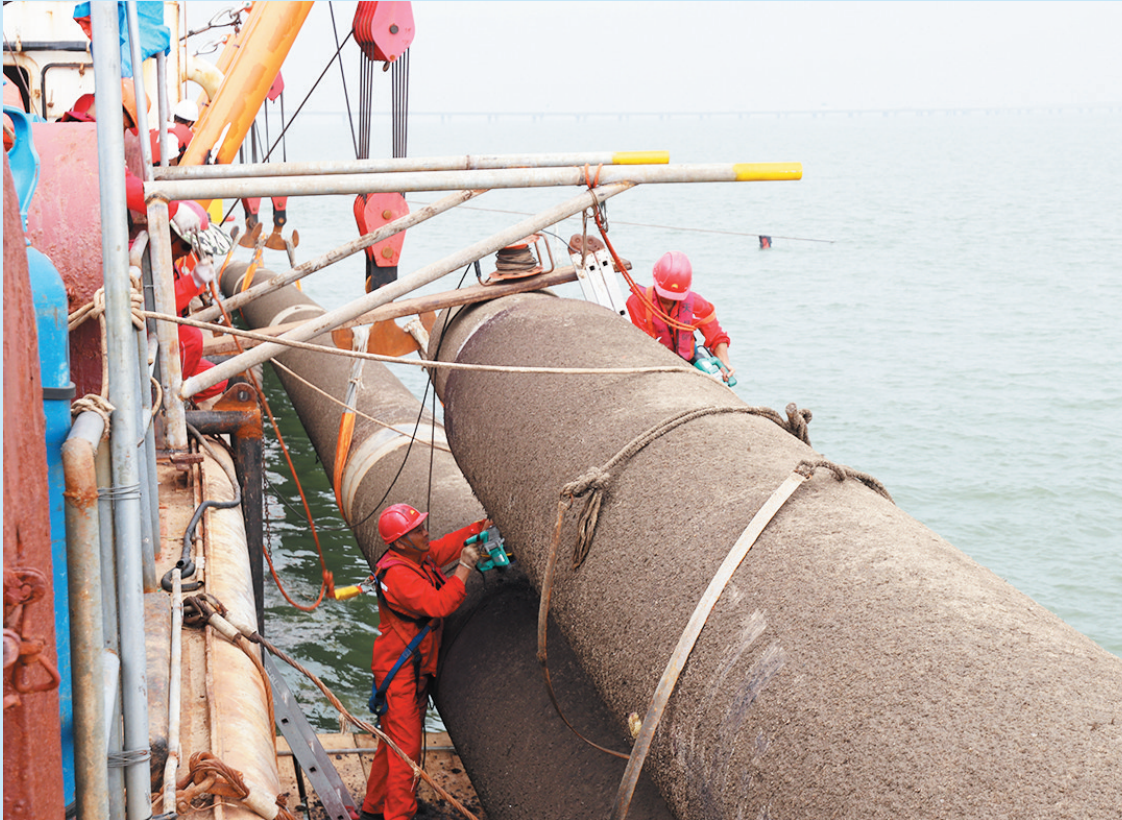
■工程建设人员正在海上平台紧张有序开展管线连头作业。
