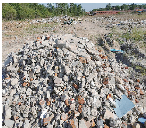
■西海岸新区李家洼子村村北的大卢河西岸遍布建筑垃圾。
