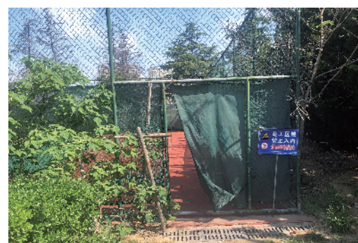
■城阳区火炬路网球场门口的施工标志。
