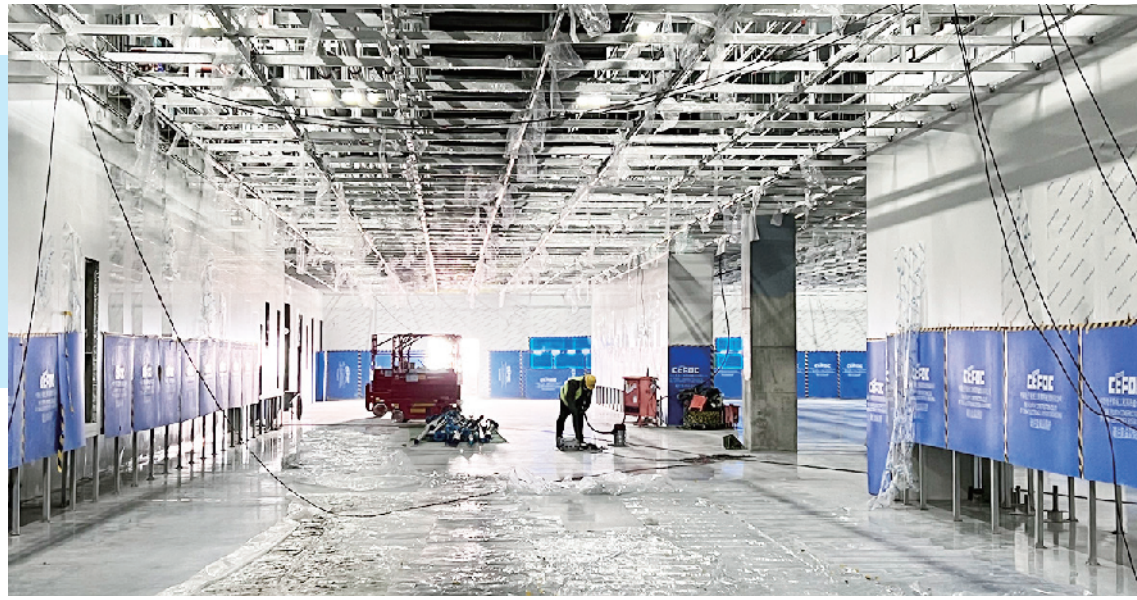
■青岛微电子产业园内,工人在洁净车间里施工。
