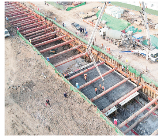
■唐河路—安顺路打通工程首段综合管廊浇筑完成。
