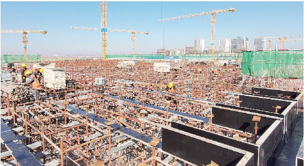
诉记者,这几天项目建设进度很快,目前基础浇筑已经全部完成,正在搭建首层模板支撑架体。“这些架体高度6.5米,总共有15万平方米。我们5天已经完成了50%,2月底就能完成全部架体搭建。”
