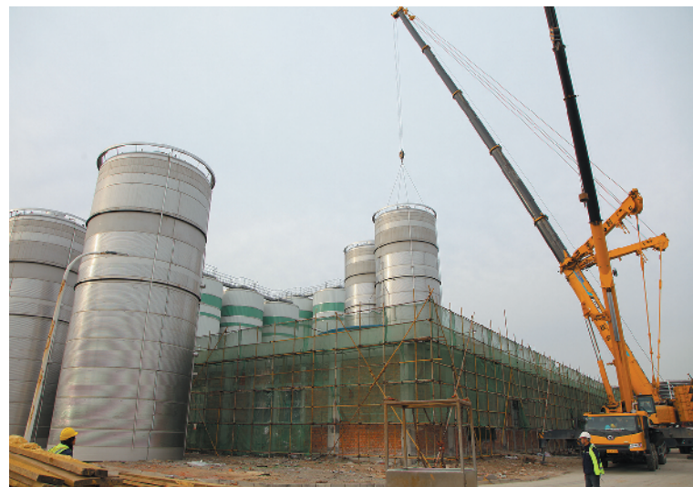
■工人操作重型机械吊装啤酒发酵罐。马英歌 摄
