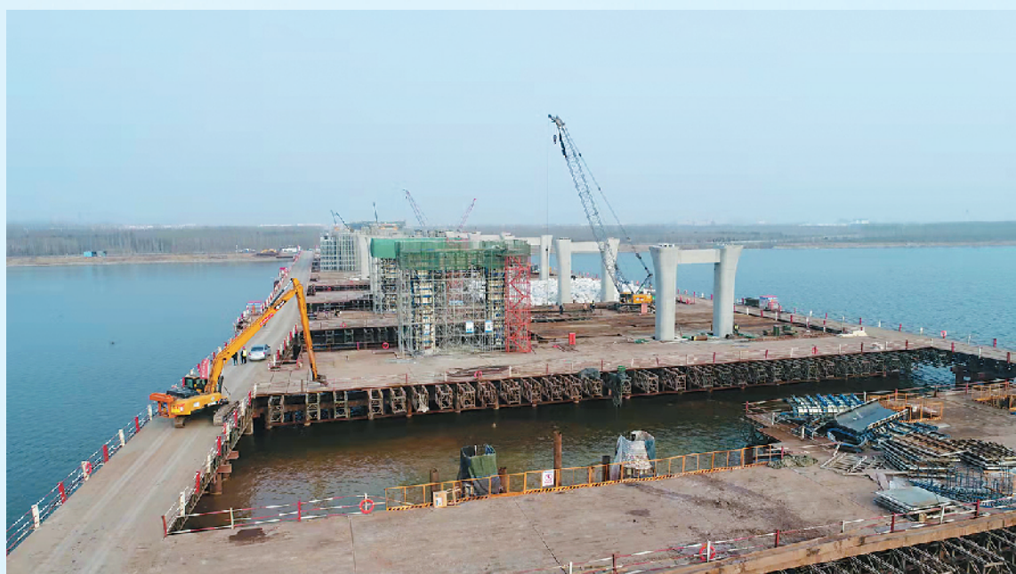
■国道204大沽河桥梁工程施工现场。
