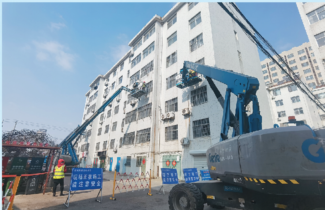
■在胶州市新立街小区，工人们正在拆除居民楼上的防盗窗和空调外机等附着物。
