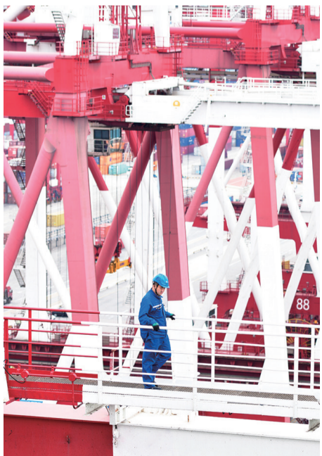
集装箱桥吊设备维护人员认真细致检查作业桥吊运行。
