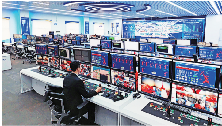
山东港口青岛港卸船机司机,正在干散货智慧码头自动化控制中心,操控卸船机进行矿石船舶卸船作业。
