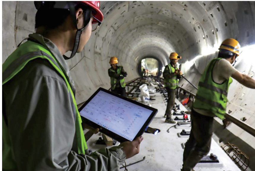
施工人员正在进行预制轨道板精调作业。青岛地铁供图
