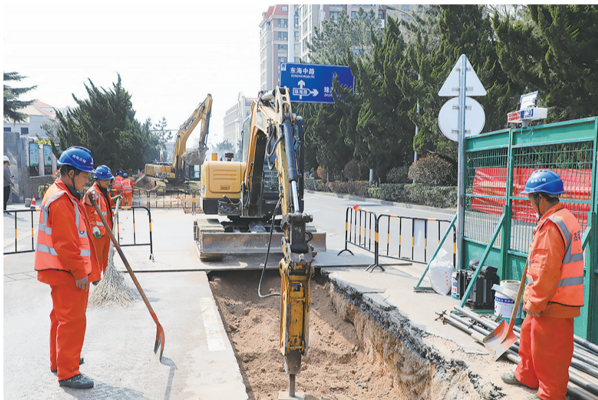
青岛能源热电集团老旧管网改造施工现场。
