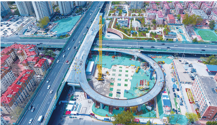
山东路一鞍山路东北象限连接匝道及地下停车场工程桥梁合龙。项目方供图
