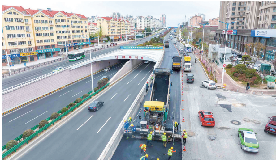
辽阳快速路沥青摊铺现场。 城建公司供图
