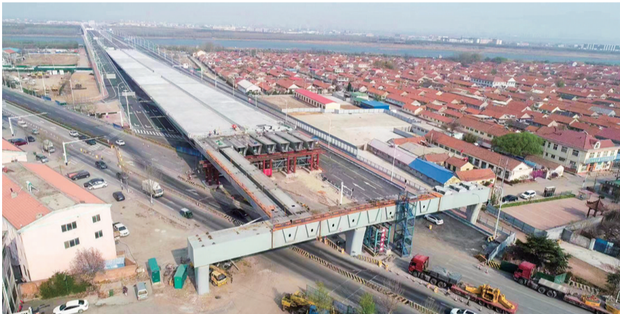
胶即快速通道项目加快施工建设。
