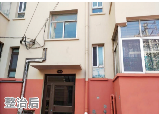
胶州市供电公司宿舍“飞线”整治后。
