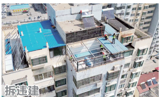
拆除凯旋花园楼顶违建。
