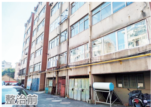
胶州市一中宿舍楼“飞线”整治前。
