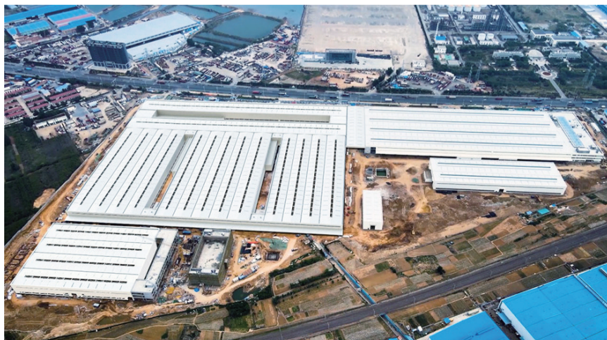
潍柴(青岛)智慧重工智造中心项目显露雏形。企业供图
