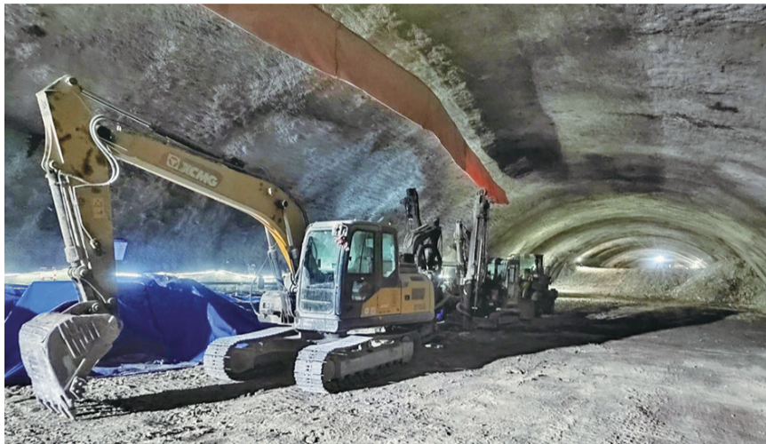
已经贯通的龙川路站主体拱部。
