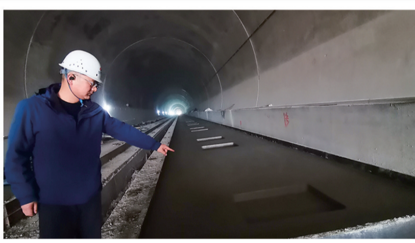
费建荣指给记者看草花山隧道内铺装的底座板。
