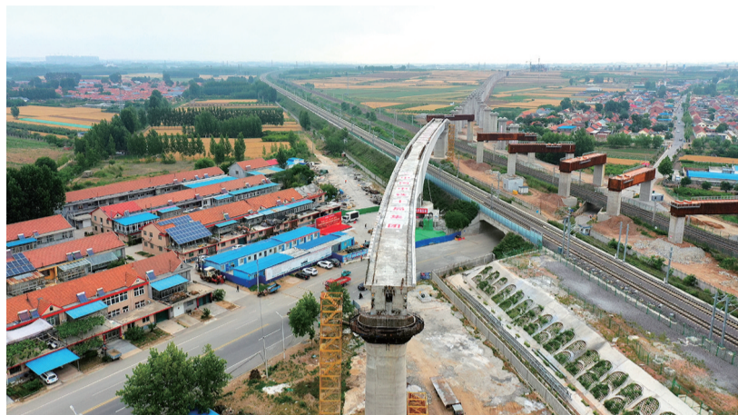
国内跨高铁最大悬臂转体桥的莱荣高铁跨青荣城际高铁转体T构合龙。资料照片
