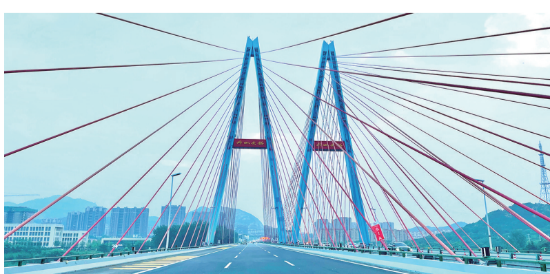
丹山大桥段主线贯通。
