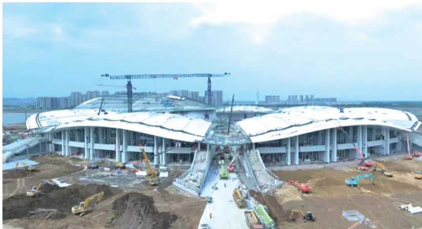
如意湖商业综合体项目建设现场。
