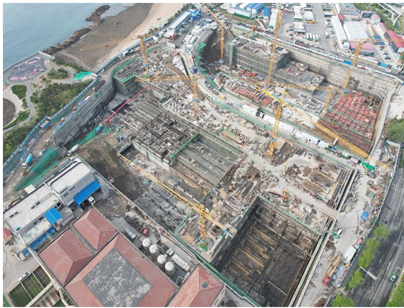
麦岛污水处理厂品质提升工程吹响主体完工“冲锋号”。
