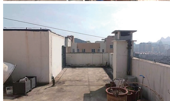
溪谷美寓小区楼顶违建拆除前后对比。
